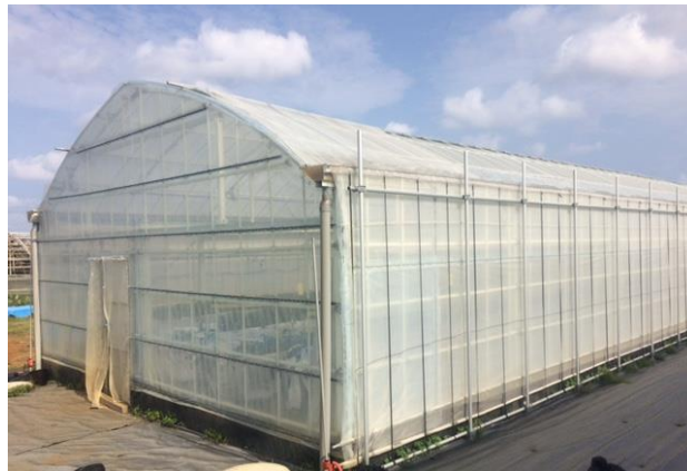
群馬県利根郡川場村に設置した「CFRP 農業用ハウス」の外観イメージ
